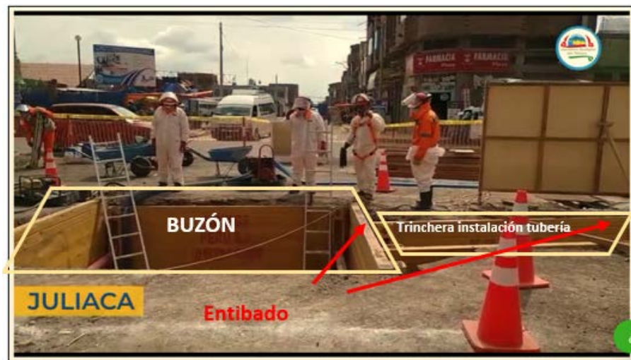
Figura 27. Utilización de entibados en el Proyecto – Localidad Juliaca 129
