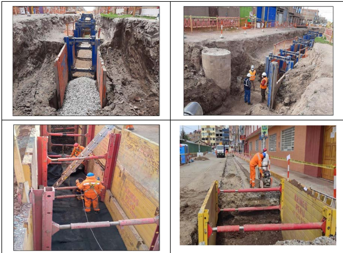
Figura 52. Uso de entibados en la excavación de zanjas.
