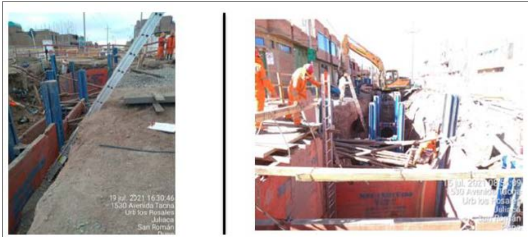
Figura 28. Utilización de entibados en el Proyecto – Localidad Juliaca, Extracto Informe Mensual No 4 del periodo del 01/07/21 al 31/07/21)
