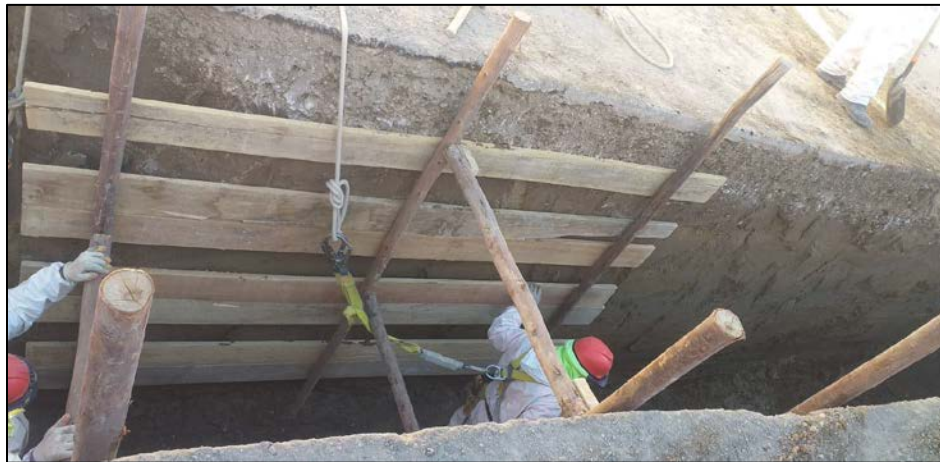
Figura 41. Colocación de entibado de madera-llave. Fuente Informe Mensual No 6, página 1420 148
